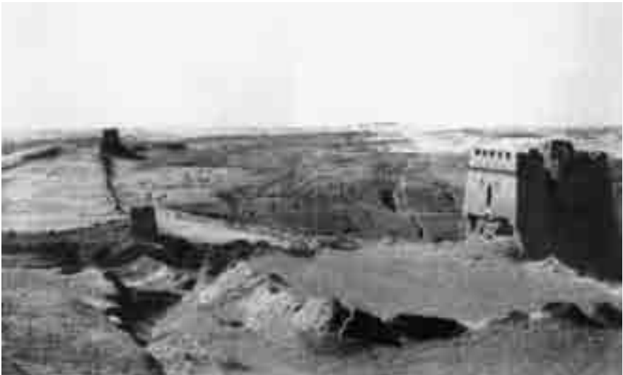
4. La muralla en la zona de Yulin en 1908, obra construida en tapial (Foto Clark y Sowerby)
