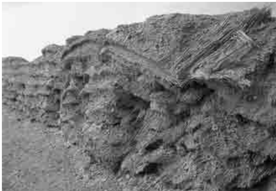
2. Tramo de la muralla construida por la dinastía Han en barro y paja en el desierto de Gobi (Fuente: W. Lindessay)
